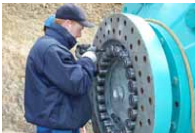
Montaż kołnierza przekładni w turbinie wiatrowej. Połączenie śrubowe z zastosowaniem napinacza Superbolt - technologia służy do przekazywania ogromnego momentu obrotowego. Rozwiązanie jest kompaktowe i minimalnie zwiększa ciężar urządzenia co było wymogiem producenta turbin.
